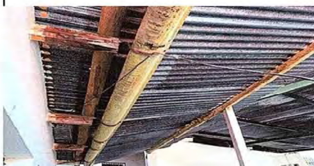
Foto 2: techo en deterioro, los canales en mal estado, entra agua en todos lados
