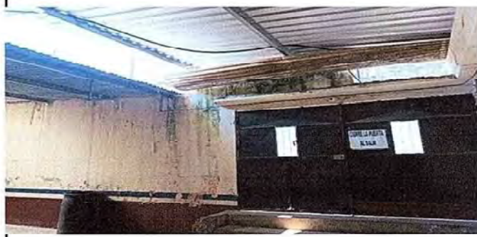
Foto 4: la puerta y el techo en esta entrada están muy deteriorados, el agua se corre directamente hacia el corredos
