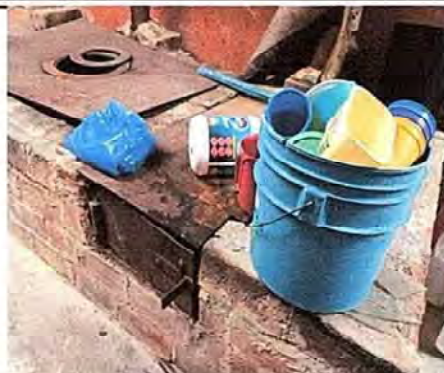
Foto 2: Son 3 planchas en mal estado y están muy bajas.
