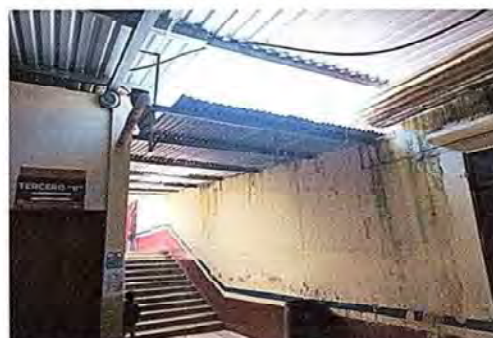
Foto 6: este entechado hay que cambiar, puesto que el agua se derrama en la entrada de las aulas por estar muy bajo.
