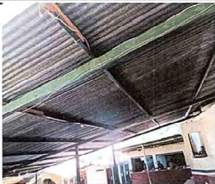
Foto 1: Techo de escenario en deterioro, hay goteros en todas partes y están muy oxidadas las costaneras.
