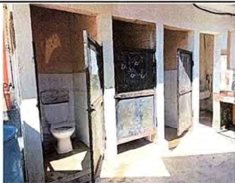
Foto 3: en los 3 sanitarios hay que cambiar los accesorios y las 3 puertas no se cierran bien.
